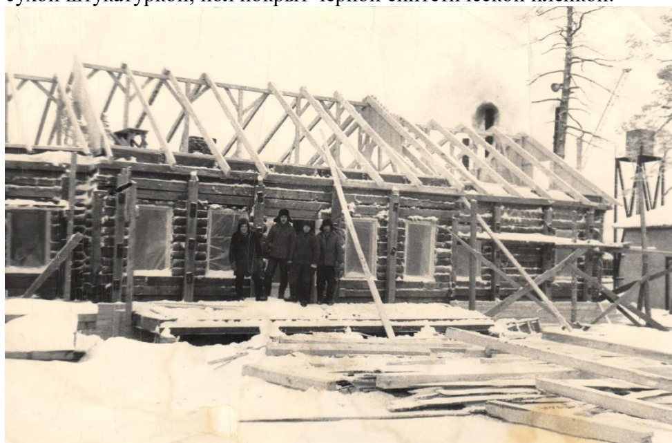
Ф.57.Оп.1.Д.16.Л.1 Общий вид строительства здания средней школы №1 п. Когалым, 1976
