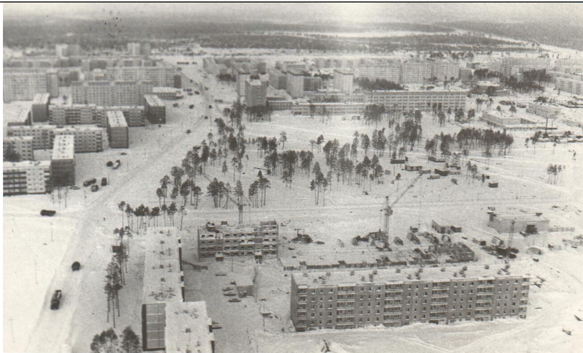
ФД.Оп.2.Д.85.Л.1 Панорама строительства жилых домов по улице Сибирской в 10-ом микрорайоне в зимнее время, 1993 год
