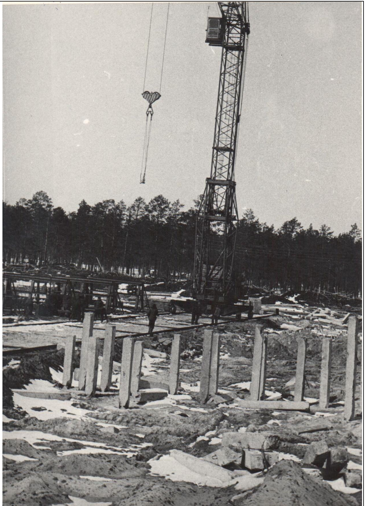
ФД.Оп.2.Д.2.Л.1Сваебойное поле под дом № 3 по улице Др.Народов . Работают строители Литвы, 1981 год
