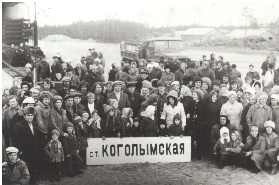
ФД. Оп.2. Д.150, Л.1 Митинг, посвященный укладке последнего звена на 91 км станции Коголымская, 20.09.1977
