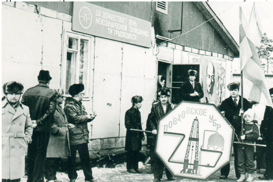
ФД.Оп.2.Д.237.Л.1 Работники Повховского управления буровых работ (ПУБР) у здания конторы с первомайскими транспарантами, 1985 год
