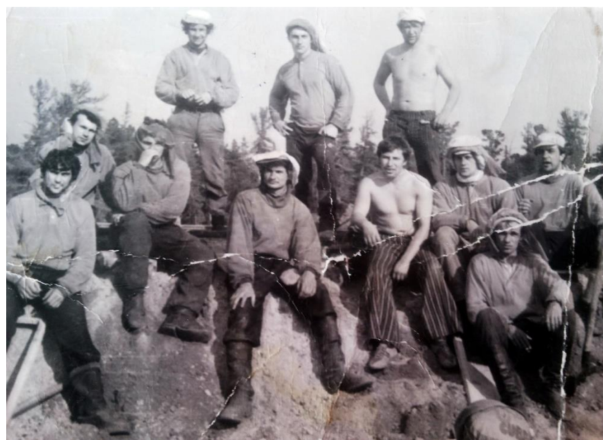
ФД. Оп.4. Д.60. Л.1. Михаил Иванович Мельниченко (третий слева во втором ряду) и другие члены стройотряда на строительстве железной дороги Сургут-Новый Уренгой, 1979 год.
