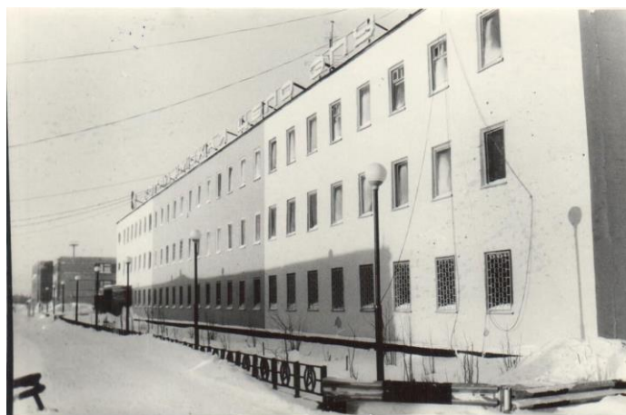
ФД. Оп.2. Д.46. Л.1 Общий вид здания Центральной базы производственного обслуживания электропогружных установок (ЦБПО ЭПУ), 1996 год.
