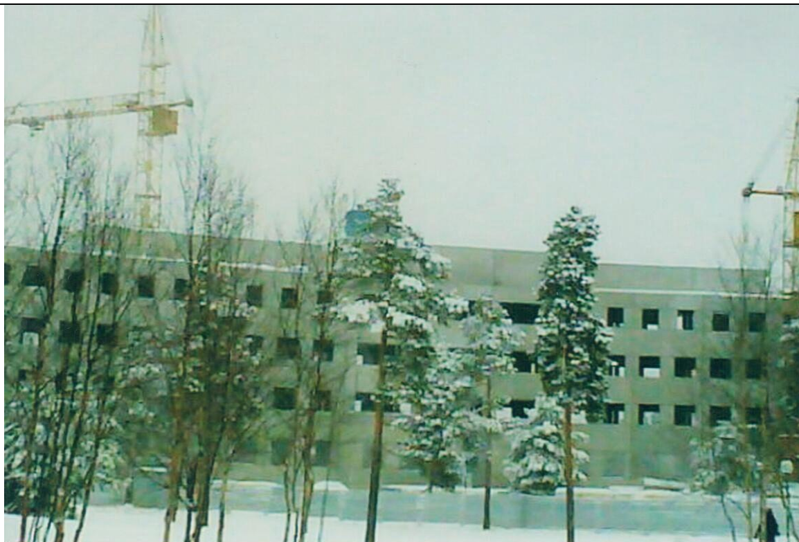
На фото: Общий вид строительства здания городского профессионального училища по улице Прибалтийской в зимнее время, 2009 год. Ф.ФД, Оп.1, Д.706, Л.1.
