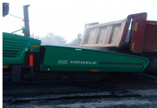
На данном участке дороги выполнены работы по замене верхнего слоя асфальтобетонного покрытия с ликвидацией коллейности и других неровностей методами холодного фрезерования, укладка выравнивающего слоя в целях исправления продольного профиля автомобильной дороги, нанесение дорожной разметки.
